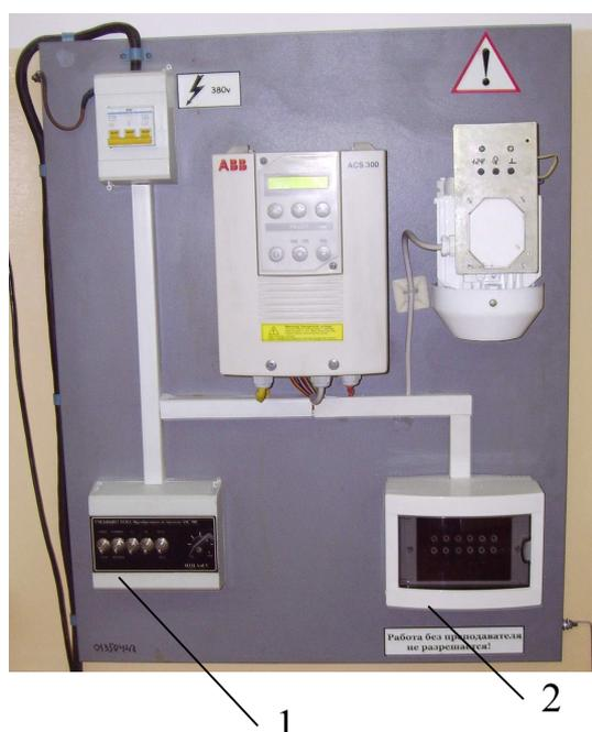
*Рис. 1.* Частотно-управляемый электропривод на основе ПЧ ABB ACS300
